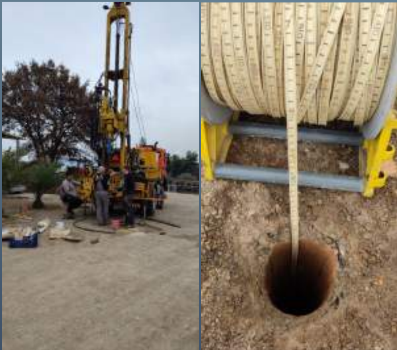
ΦΩΤ. 1: ΘΕΣΗ ΑΝΟΡΥΞΗΣ ΓΕΩΤΡΗΣΗΣ ΝΕΡΟΥ ΔΓ3 & ΕΛΕΓΧΟΣ ΒΑΘΟΥΣ ΔΙΑΤΡΗΣΗΣ
